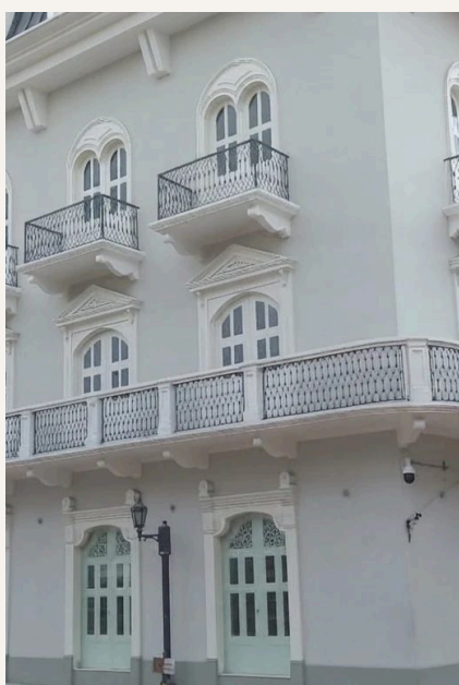
Edificio en Casco Viejo
